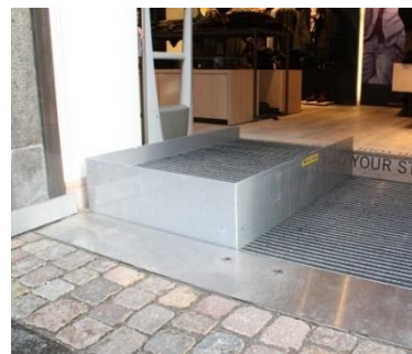
Elevador en la posición superior, listo para que el usuario se suba o se baje
