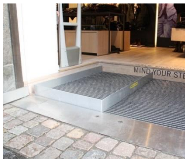
Zócalos de seguridad levantados
