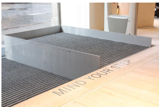
Elevador HDN listo para ser utilizado en el nivel superior
